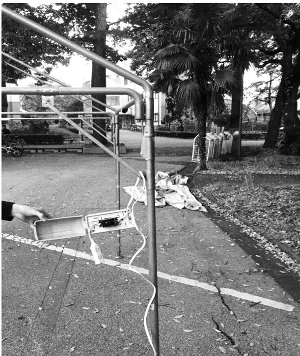
ブレーカーは左の写真のように、テントの梁と支柱を繋ぐ棒にコードを引っ掛けて設置してください。また、ブレーカーボックスが地面に接しないように気を付けてください。
