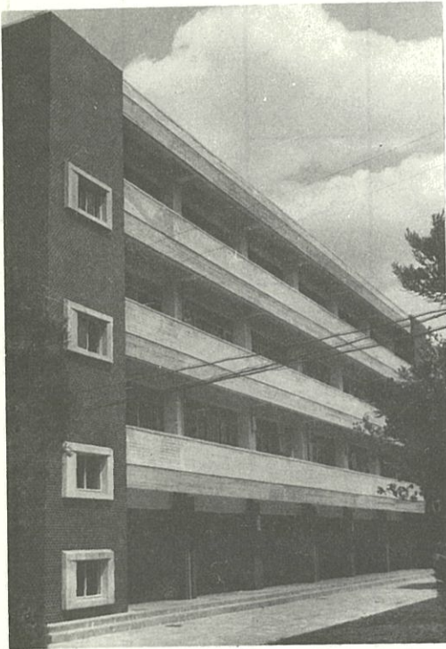
新設なったA棟
